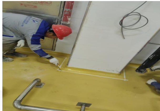
R角阳角位置处理
